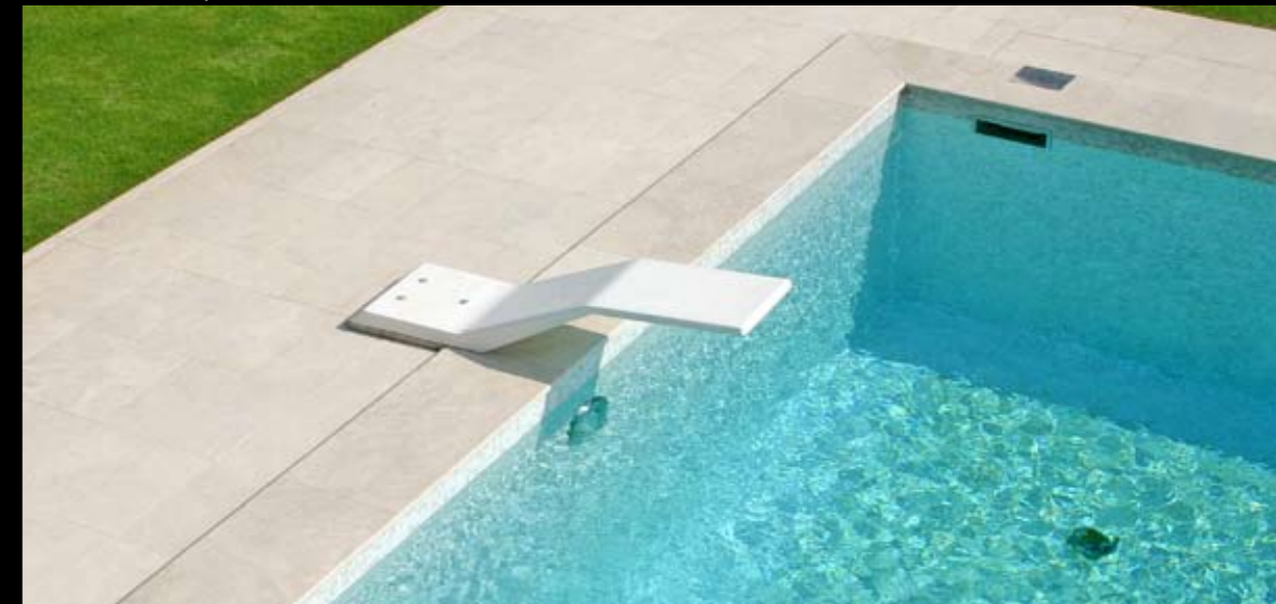
Pavimento e bordo piscina in travertino
